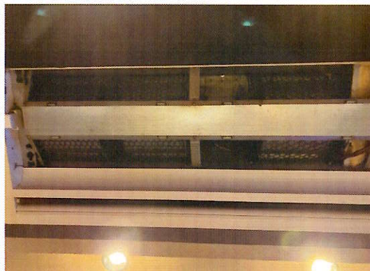
【施工後：エアコン（コンティニューム取付）】
