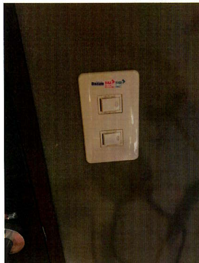
【施工後：スイッチ】
