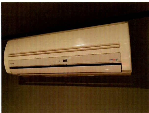
【施工後：ホール エアコン①】
