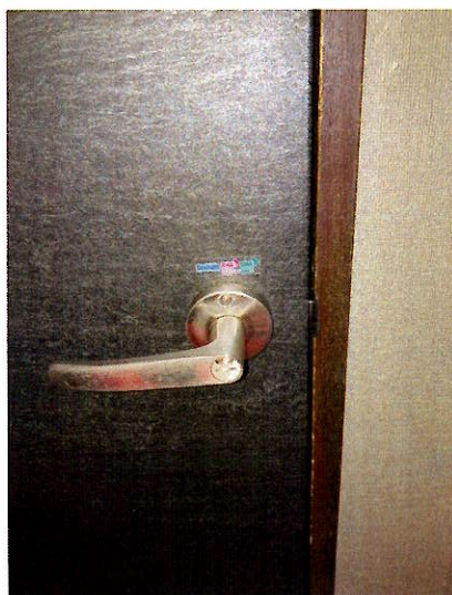
【施工後：ドアノブ】
