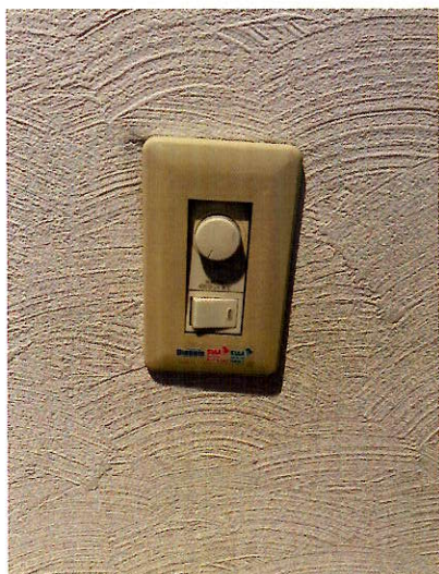
【②トイレ】写真は一部抜粋
