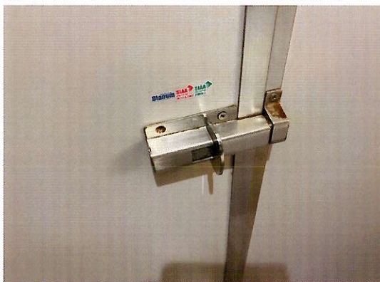
【施工後：個室トイレドアノブ（内側）】
