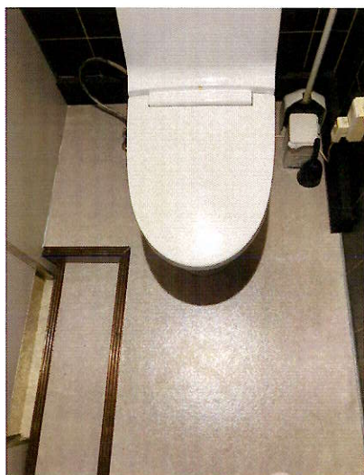
【施工後：個室トイレ：床】
