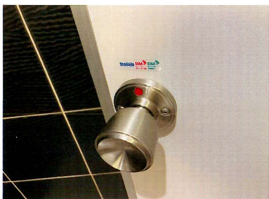
【施工後：個室トイレドアノブ（外側）】
