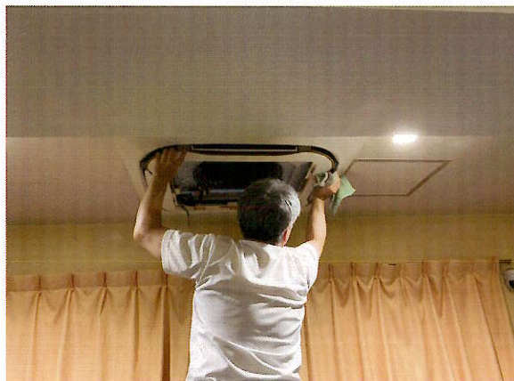
【施工中：エアコン本体（掃除①）】
