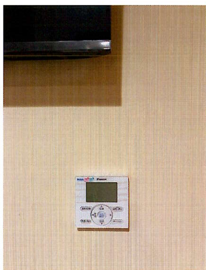
【施工後：エアコン：リモコン①】
