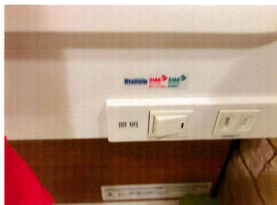
【施工後：洗面③】
