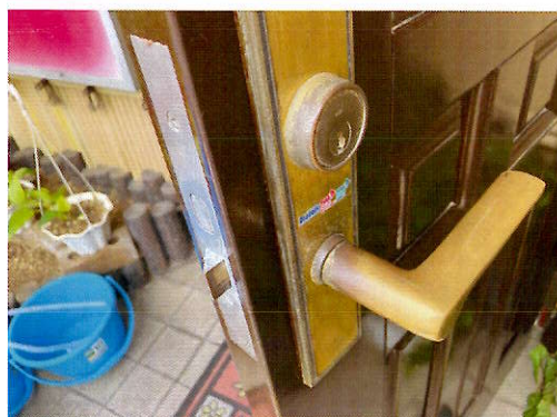
【施工後：玄関ドアノブ（室外側）】
