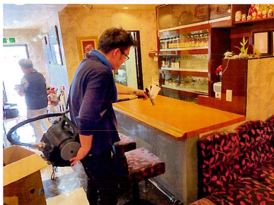
【施工後：レジ上スイッチ】
