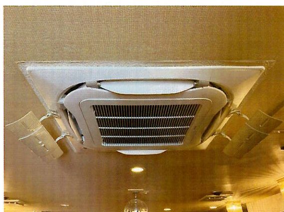
【施工後：天井カセット型】
