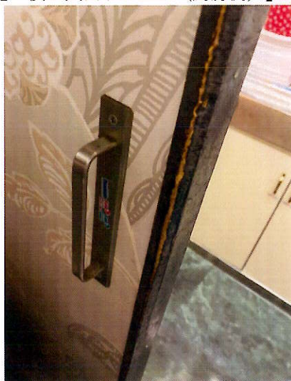
【施工後：入口ドアノブ（厨房側）】
