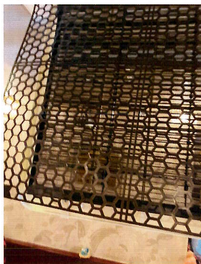
【施工後：天井カセット型（CONTINEWM取付）】
