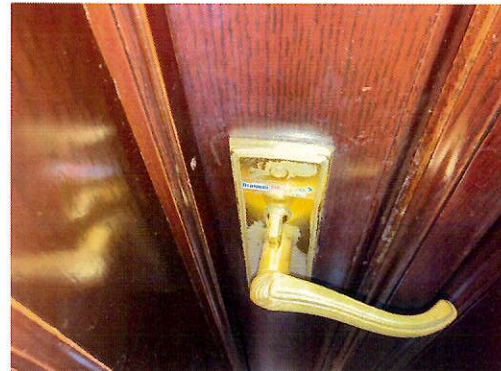
【施工後：トイレ入口ドアノブ（洗面側）】
