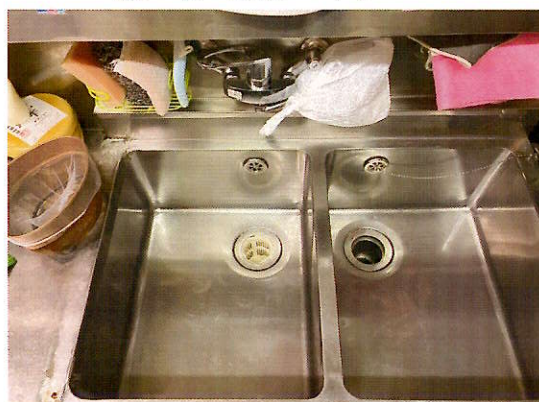
【施工後：厨房シンク】
