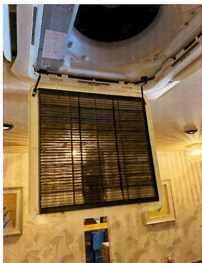
【施工後：天井カセット型】
