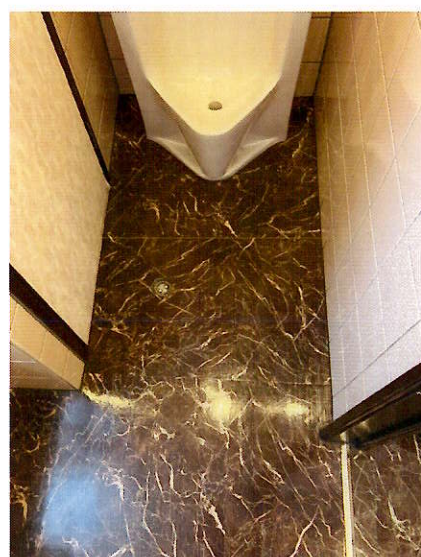
【施工後：小便器前（床）】
