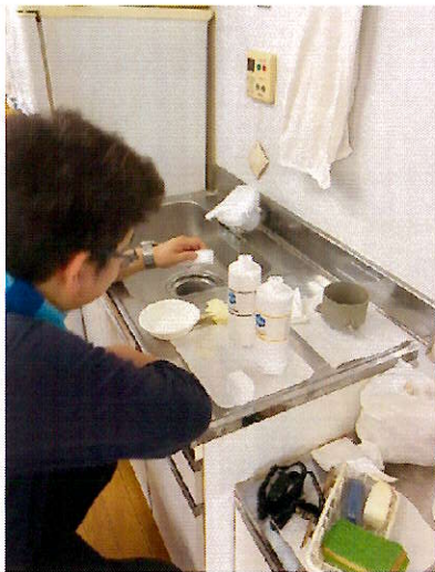
施工中【キッチン（シンク・排水）塗込】一部抜粋
