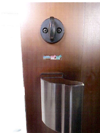
施工後【スイッチ・リモコン・取っ手等 塗込】一部抜粋
