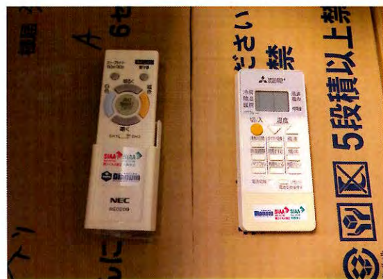
【施工後：エアコン（リモコン）・照明リモコン】
