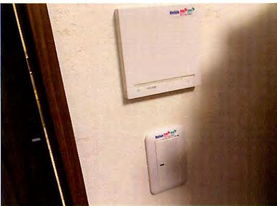
【施工後：リモコン・スイッチ】
