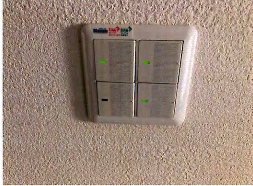
【施工後：スイッチ】
