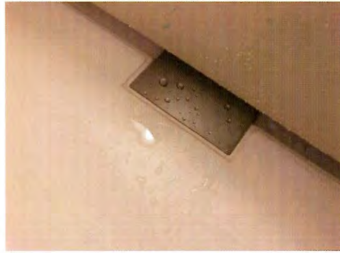
【施工後：浴室排水：撥水】
