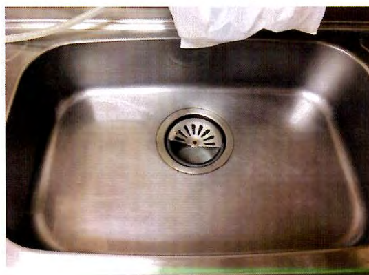
【施工後：キッチン（シンク）】
