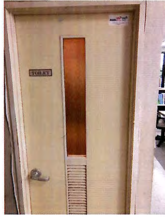
【施工後：トイレドア】
