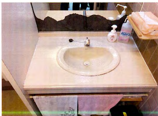
【施工前：トイレ洗面カウンター】
