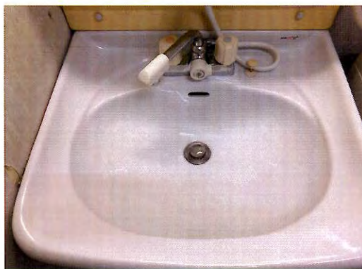
【施工後：洗面手洗器】
