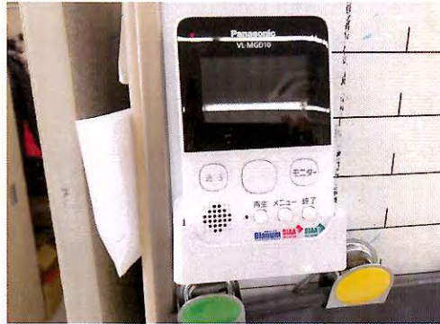
【施工後：屋内インターホン】
