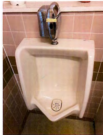
【施工後：トイレ小便器】
