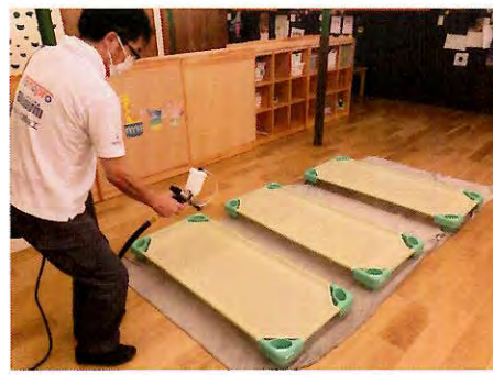
【2F（幼児用ベット）施工中】
