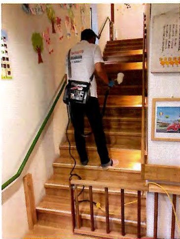
【階段（床・手摺・壁）施工中②】
