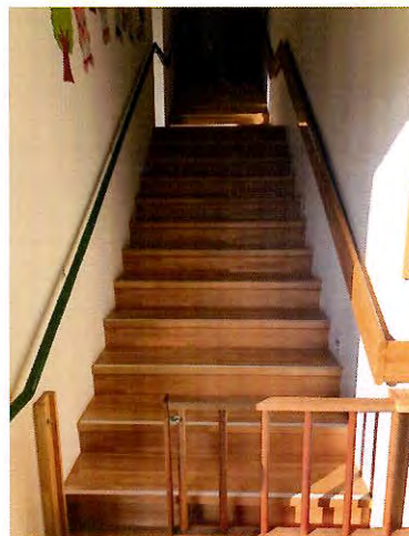
【階段（床・手摺・壁）施工後】
