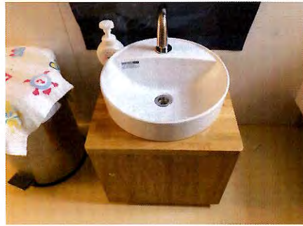
【1F（幼児用トイレ②）施工中】
